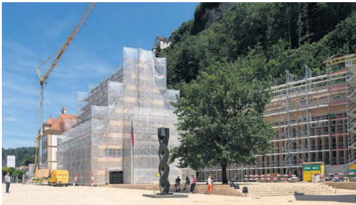
Zwei Kleine Anfragen gab es auch zur Sanierung des Landtagsgebäudes.
