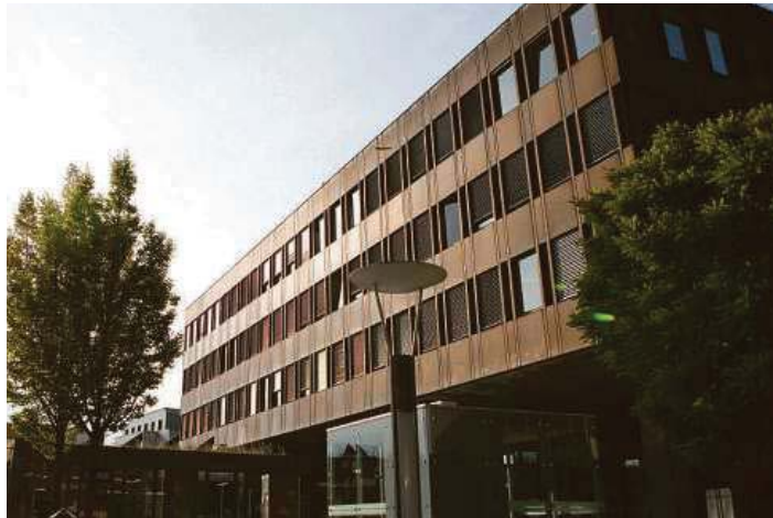
Das Post- und Verwaltungsgebäude in Vaduz soll ab 2025 die Landesbibliothek beherbergen. Bild: Daniel Schwendener
