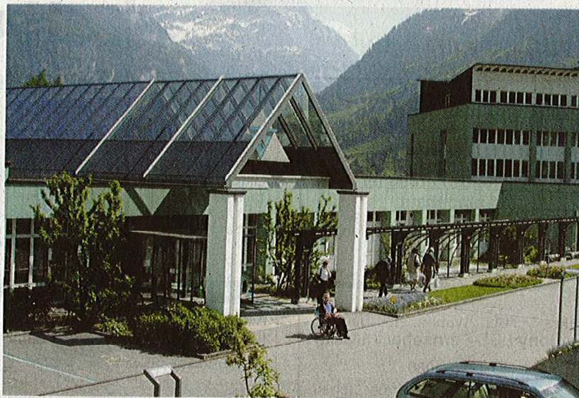
Haben die Zusammenarbeit mit der Liechtensteinischen IV-Versicherung bekräftigt: Die Kliniken Valens.
