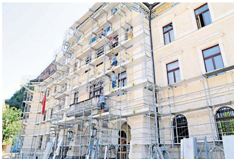
Aufnahme von der Sanierung des Regierungsgebäudes 2011: Der Staatshaushalt bleibt weiter die grosse Baustelle der Landespolitik. (Symbolfoto: Paul Trummer)
