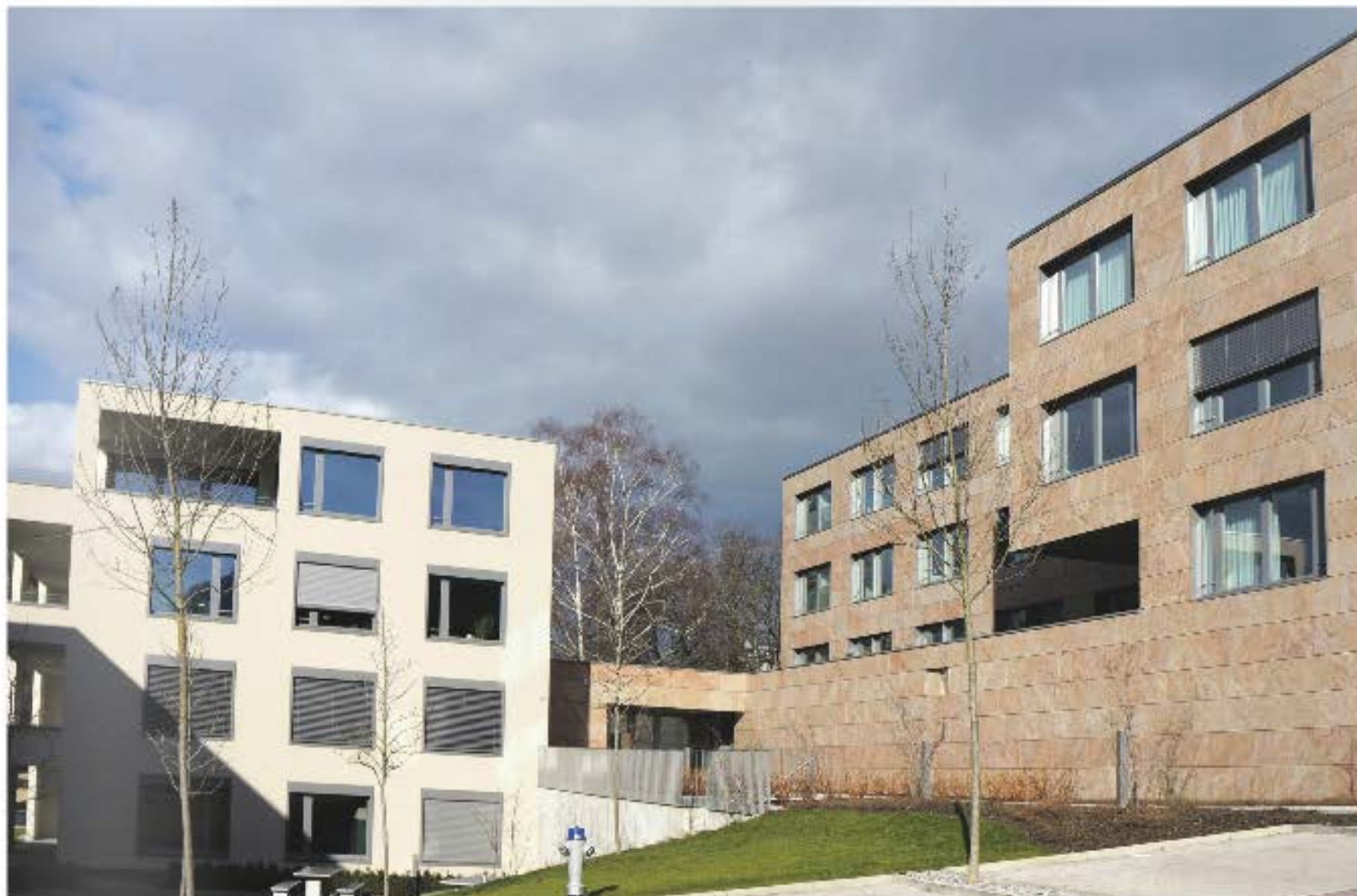
In diesem Gebäudekomplex ist die Finanzmarktaufsicht (FMA) untergebracht.
